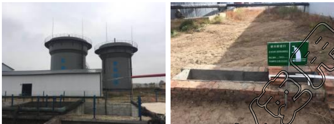
图 3-1 污水处理站现场照片
