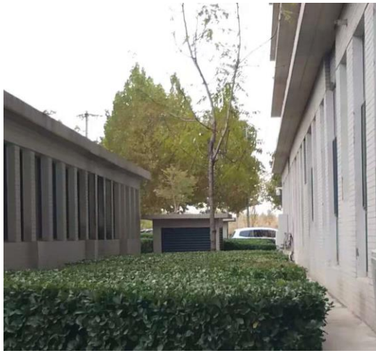
图 4.1-2 项目地下车库送排风竖井
