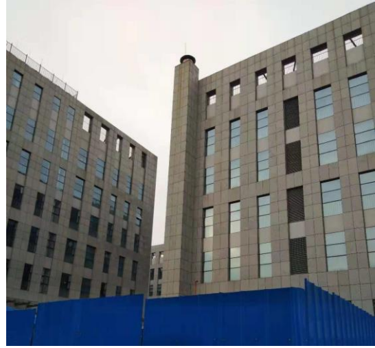
图 4.1-3 项目锅炉房锅炉排口
