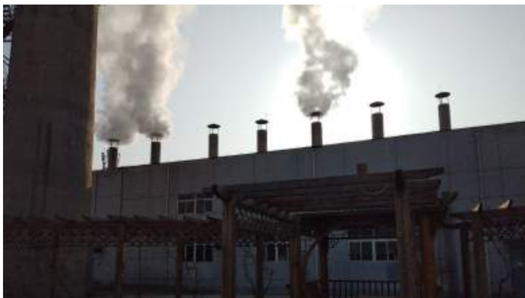
图 3-1 项目 7 个 15m 高排气筒
