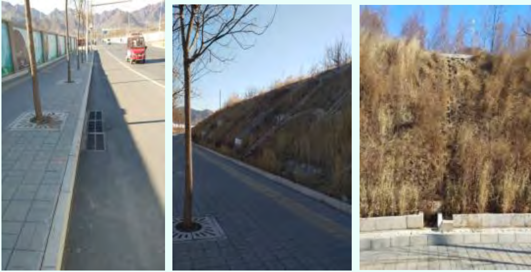
图 5.3-1 道路集水井、边坡防护（雨水边沟、拱形混凝土植被护坡、网格混凝土植被护坡）
