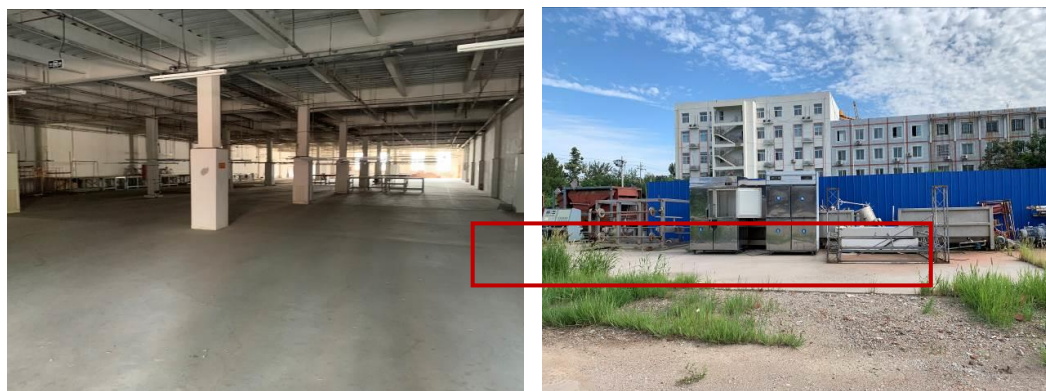
图 2- 4 一层车间（左）原危废库、原辅料库（右）现状照片
