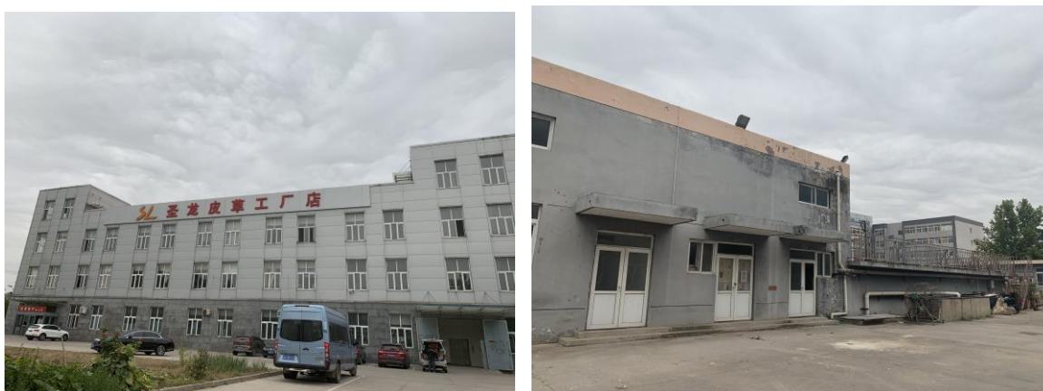
（左：一楼为原生产车间、右：原化验室、泵房、污水处理站）
