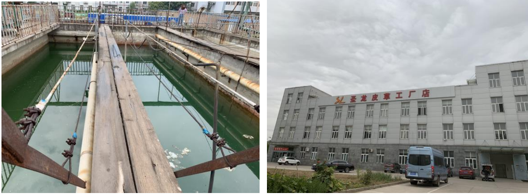
图 2-5 污水处理站停用照片（左）、龙顺建筑（右）现状照片
