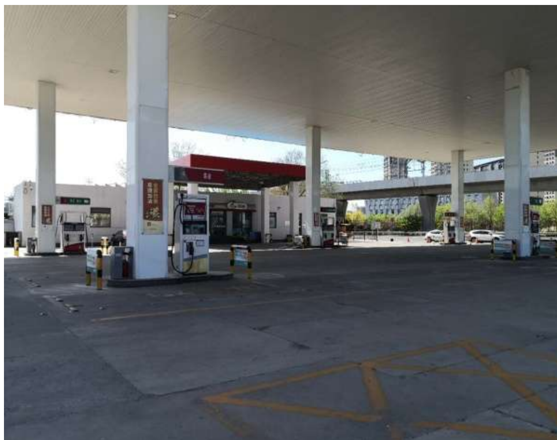
地块拆迁前加油机位置
