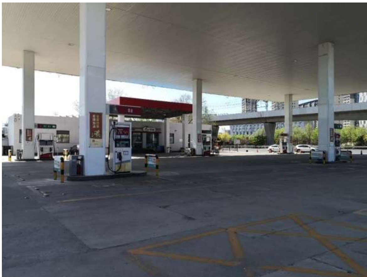
地块拆迁前加油机位置
