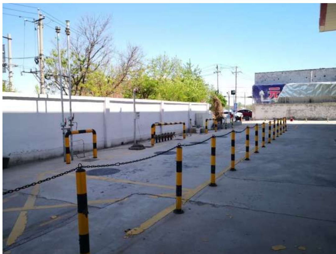
地块拆迁前油库位置
