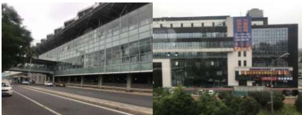
（左：北侧园博园南路及张郭庄地铁站；右：东北侧政企合作大厦）
