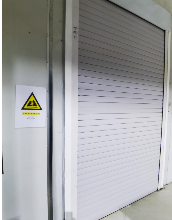
图 4-5 危险废物暂存间
