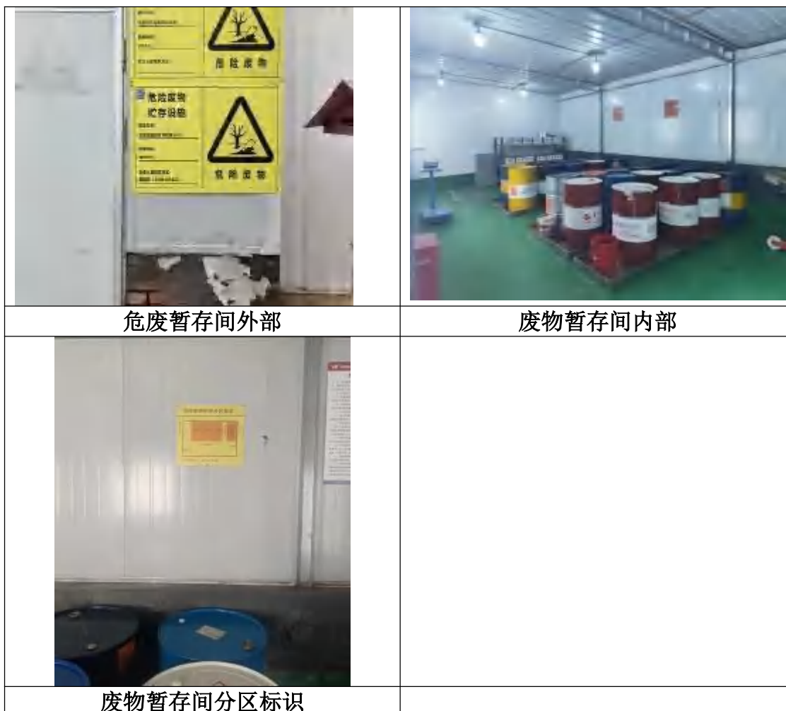
图 2-20 现有工程危废暂存间照片
