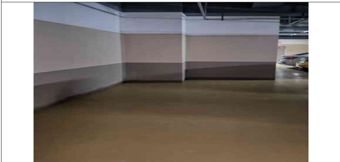
B1本项目污水处理站区域
